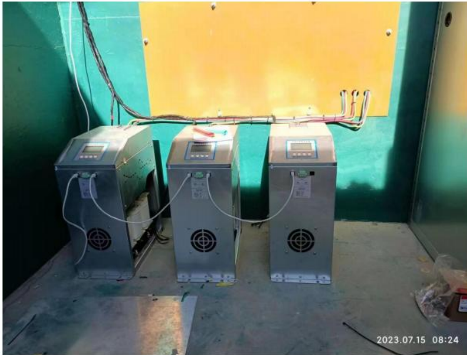
焦作充电桩现场安装图
