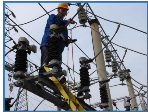
现场测试照片
