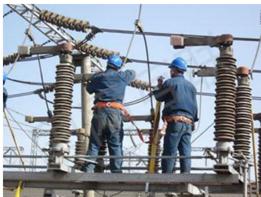
紫草鄂 110kV 变电站电容器接头 (2009 年)
