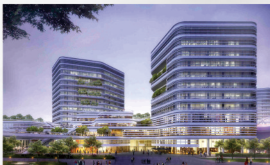
上海漕河泾科技绿洲项目
