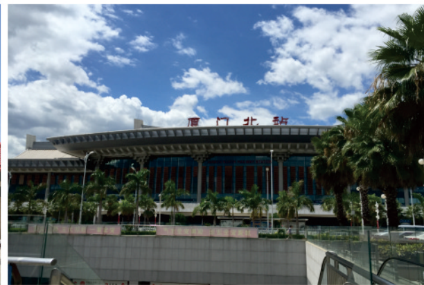
厦门北第二动车站项目
