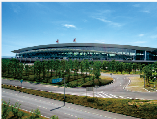
武汉机场项目
