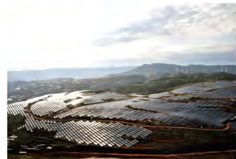
项目地:贵州黔南州 容量:200MW 解决方案:固定地面电站
