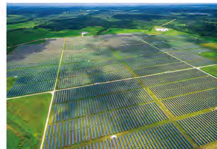
项目地:河北承德丰宁县 容量:150MW 解决方案:固定式支架系统
