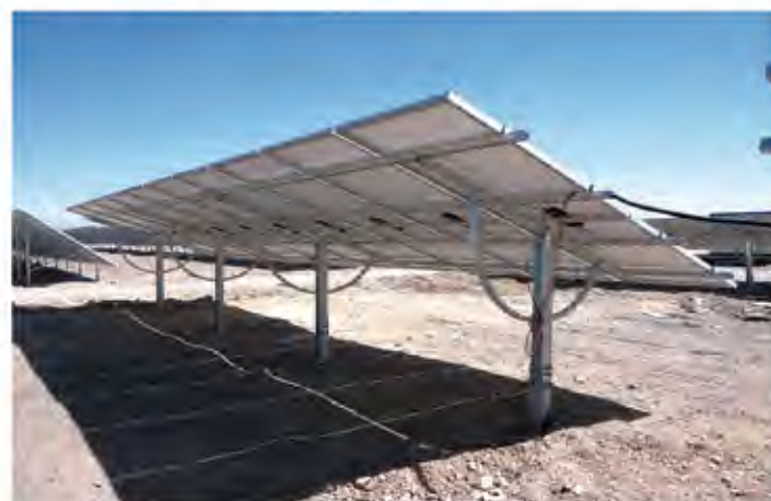
圆弧支撑系统 Arc strut system
