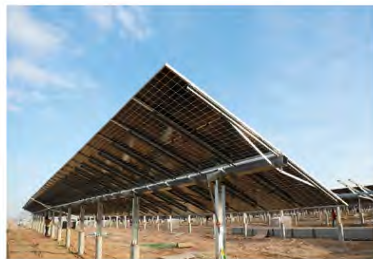
项目地:水电四局金塔县 容量:300MW 解决方案:固定式支架系统
