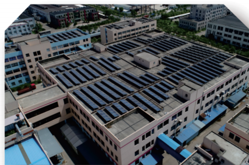
浙江屋顶光伏电站项目 (3MW) Roof Top PV Project in Zhejiang
