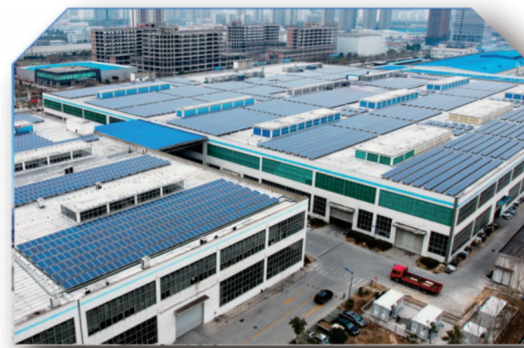
安徽合肥屋顶分布式光伏电站群 (10MW) Roof Top PV Projects in Anhui
