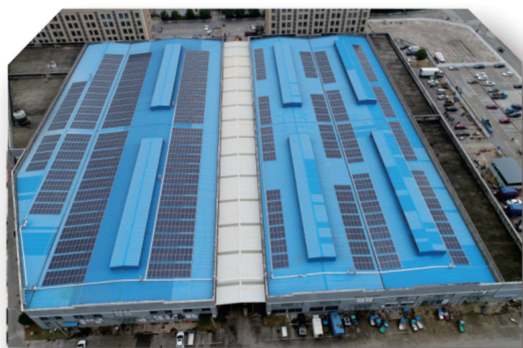
浙江屋顶光伏电站项目 (5MW) Roof Top PV Project in Zhejiang
