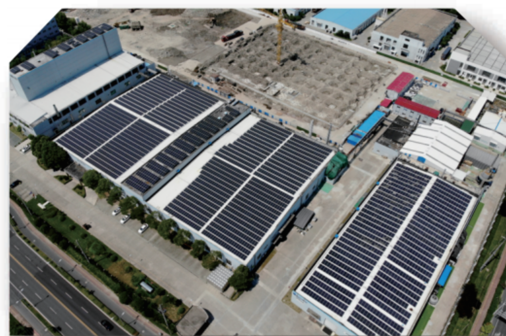
江苏屋顶光伏项目 (3MW) Roof Top PV Project in Jiangsu
