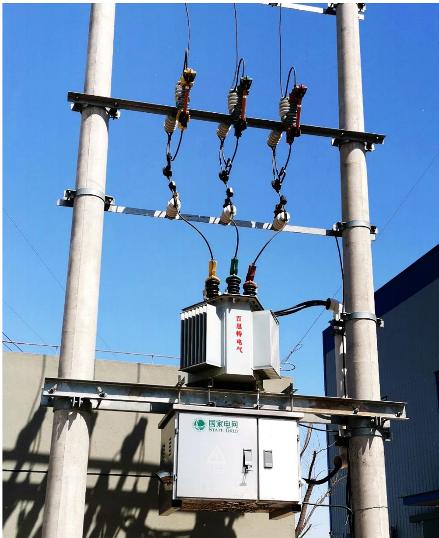
柱上安装示意图（此图为双杆正装）
