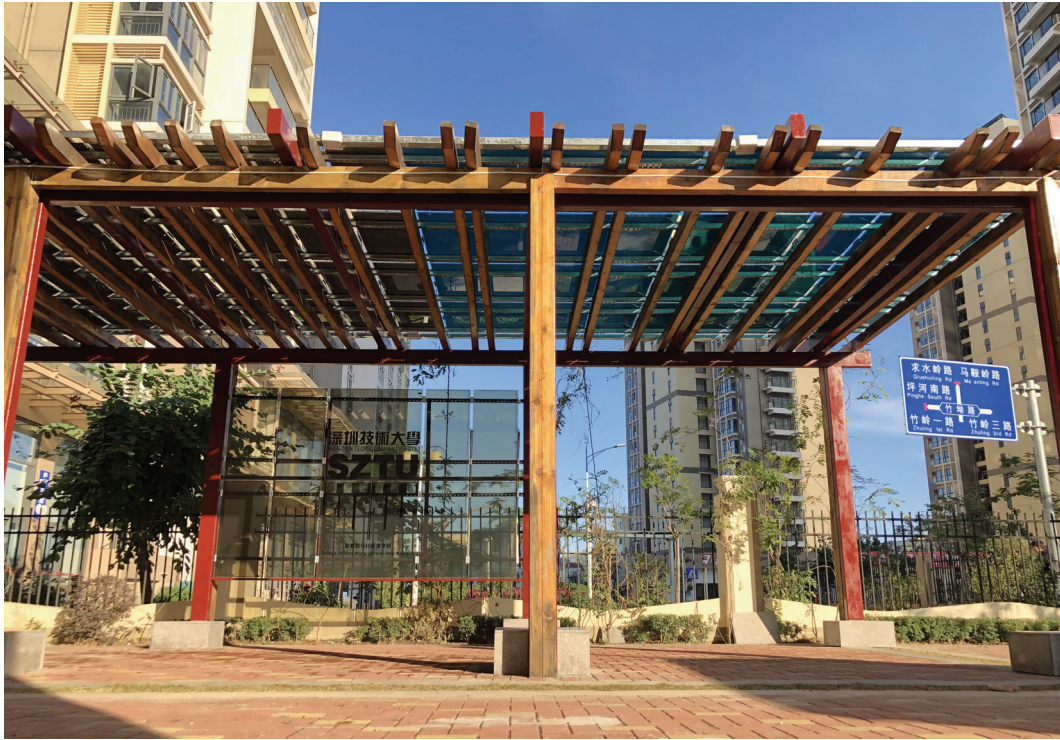
深圳技术大学光伏遮阳棚
