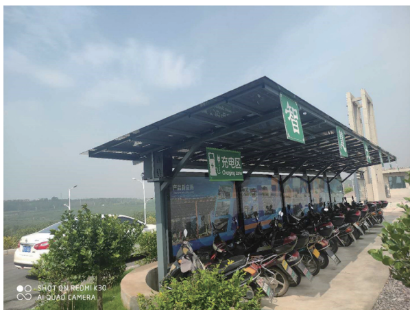
■ 阳泰龙焱厂区光伏车棚
