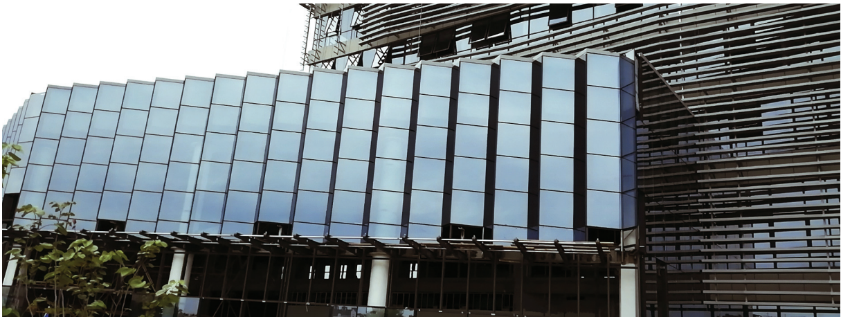
■ 陕西渭南大数据中心幕墙项目
