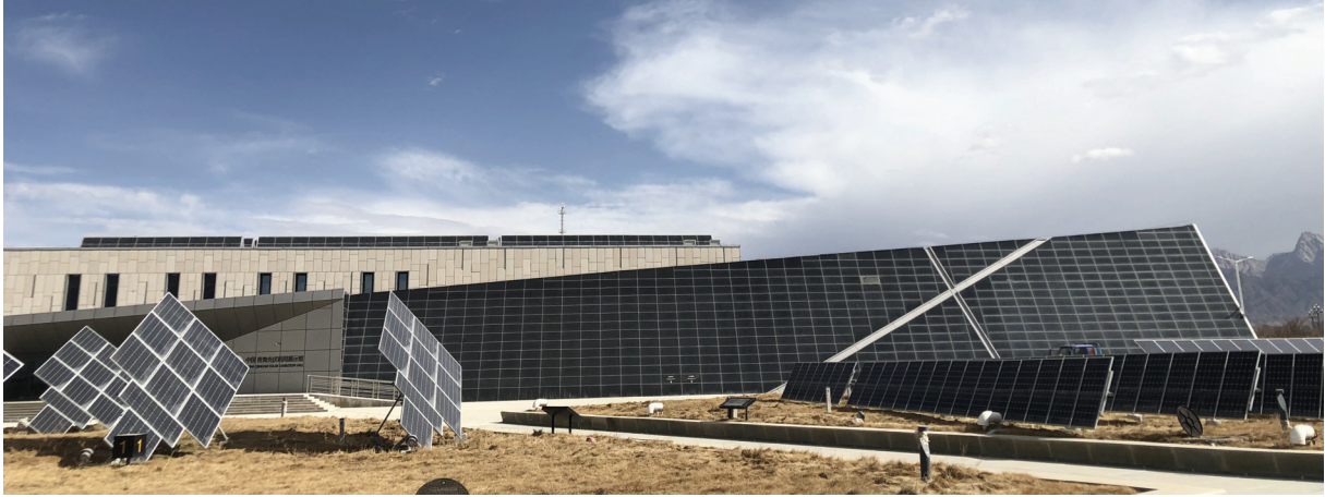
■ 青海幕墙展示馆幕墙
