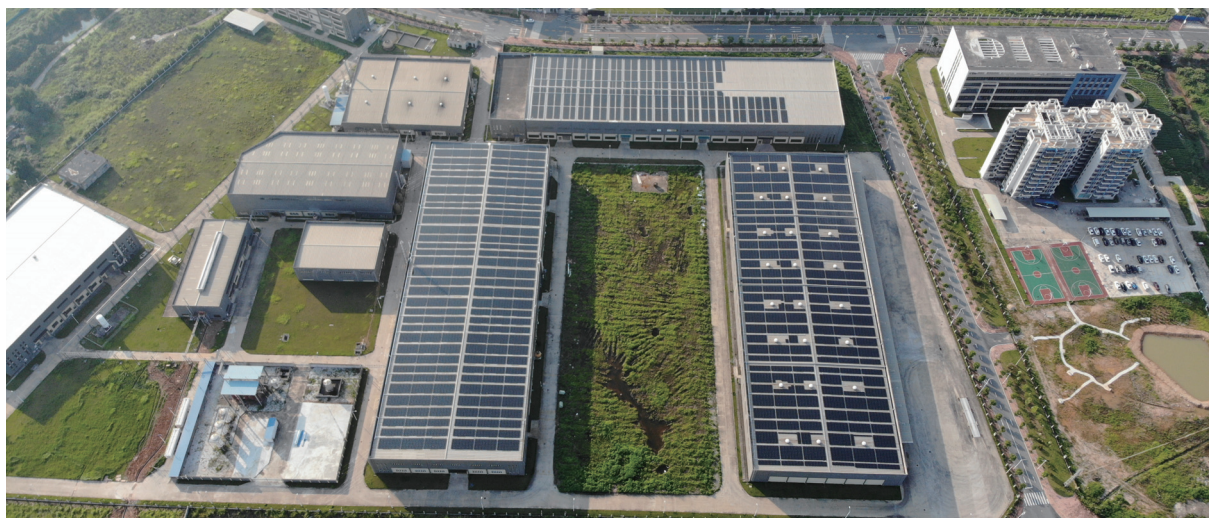
■ 清远4.8MW屋顶光伏电站
