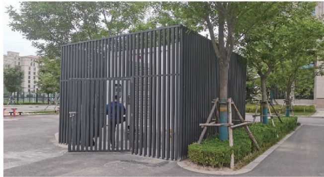
西安某光储充储能项目
