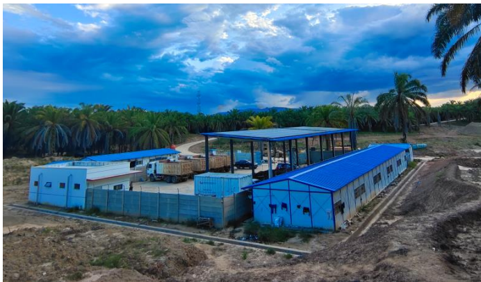
华电印尼离网光储微网项目
