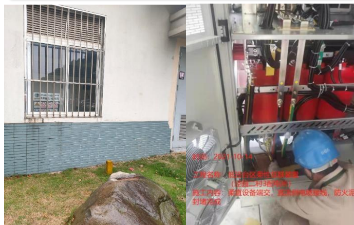
苏州工业园区低压柔性互联项目
