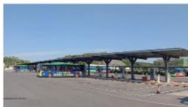
永川公交充电站
