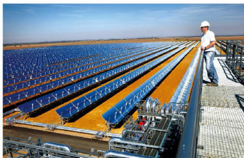
■ 无锡光伏发电站
