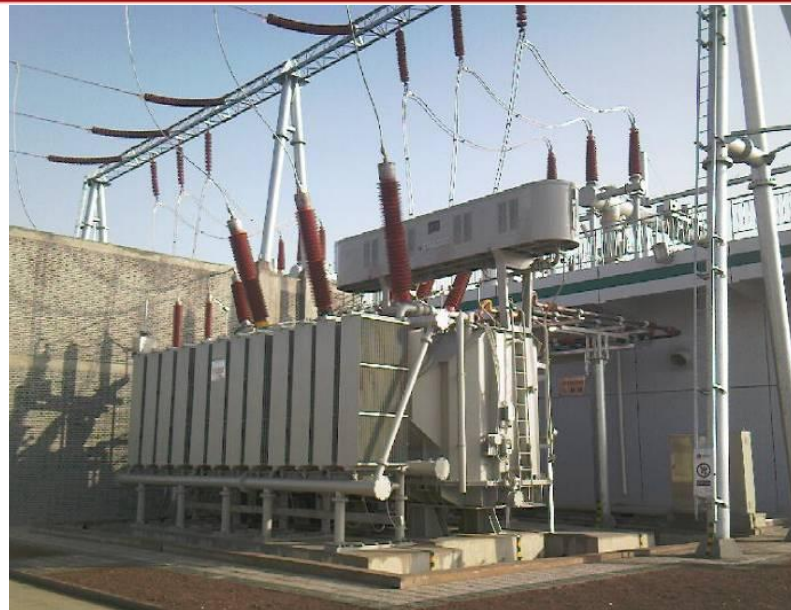
SSZ11-150000/220 (山西省电力公司临汾古城变电站)
