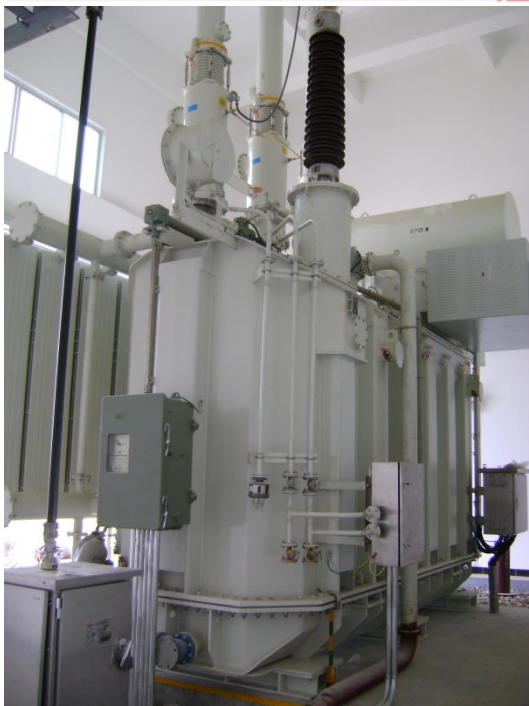
SZ11-31500/220电力变压器 宁德核电工程
