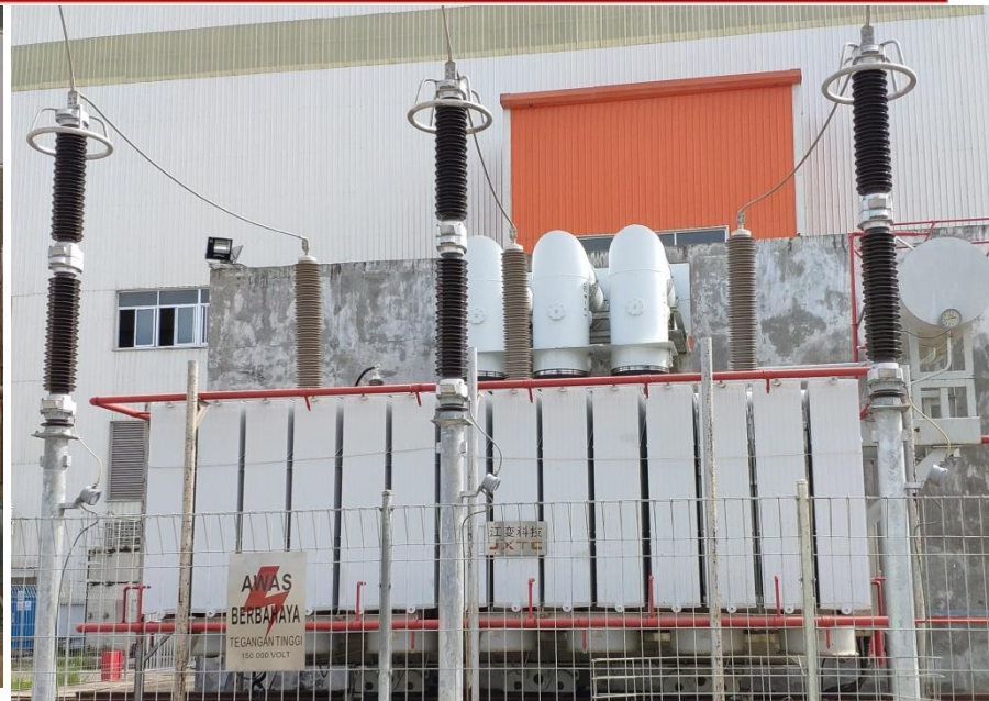
SFZ11-140000/150 东方电气（印尼卡尔滕 (Kalteng-1) 2×100MW燃煤电站项目主变)
