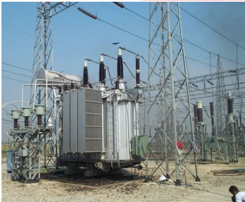
出口尼泊尔国家电力公司SFZ11-63000/132电力变压器
