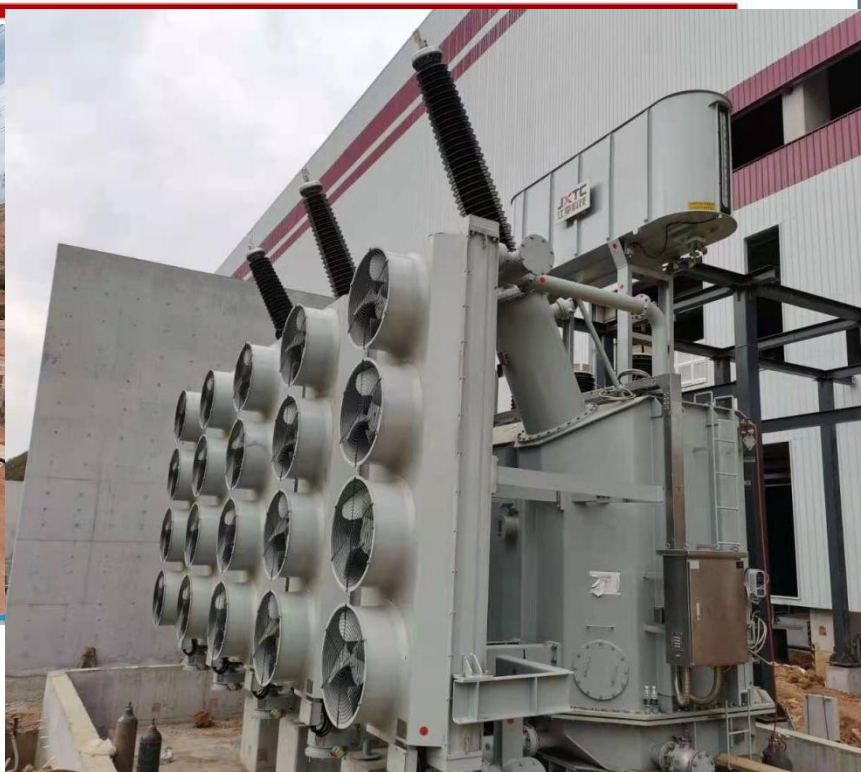
SFP11-480000/220 发电机变压器
